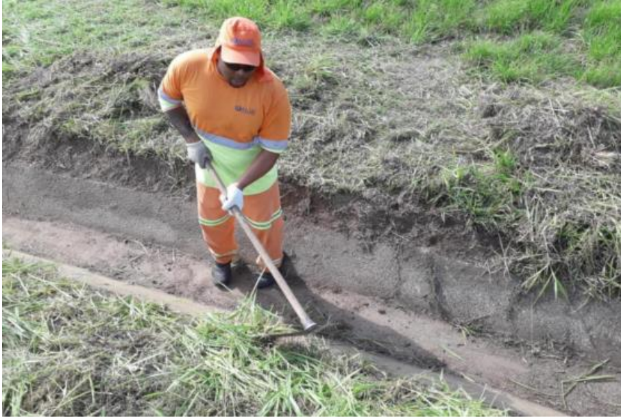
FOTO 05 – Limpeza de Canaleta - Km 56+800 Norte
