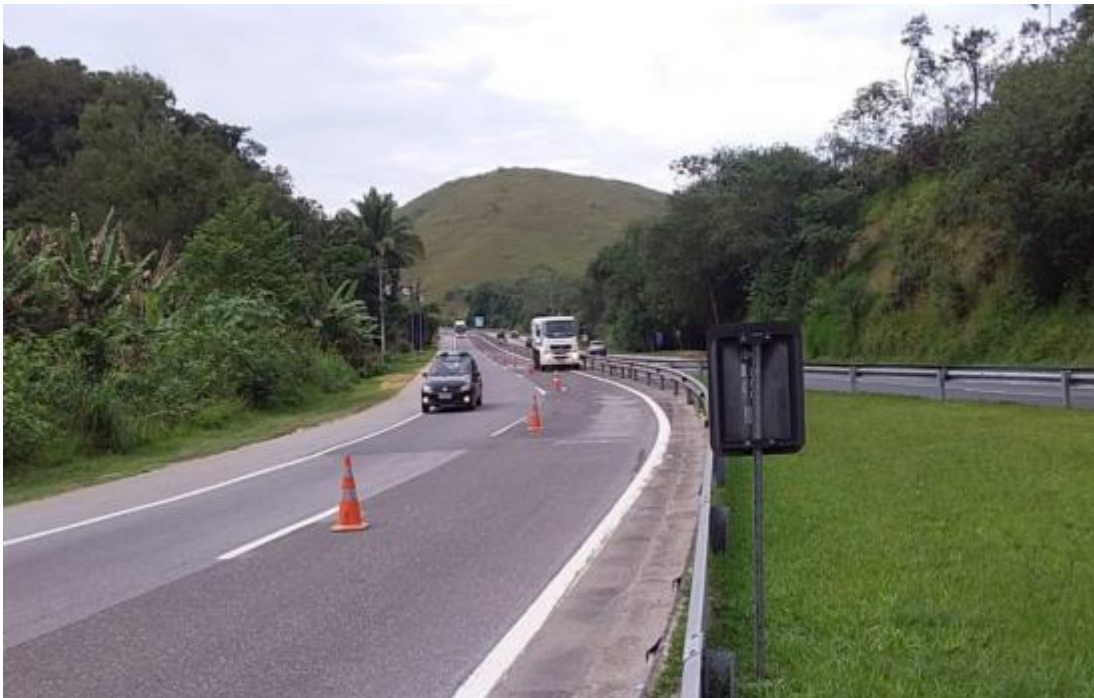
FOTO 08 – Varrição de Mediana - Km 02+000 Sul
