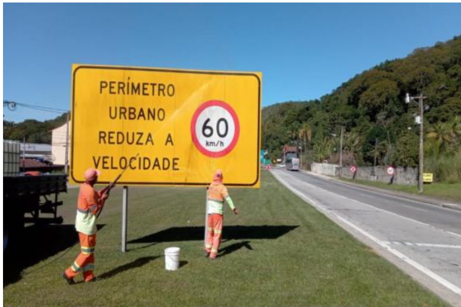
FOTO 02- Limpeza de Placa - Km 00+700 Norte
