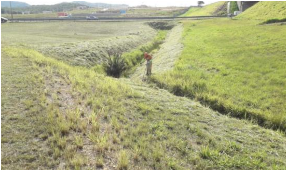
FOTO 06 – Roçada Manual - Km 56+800 Norte
